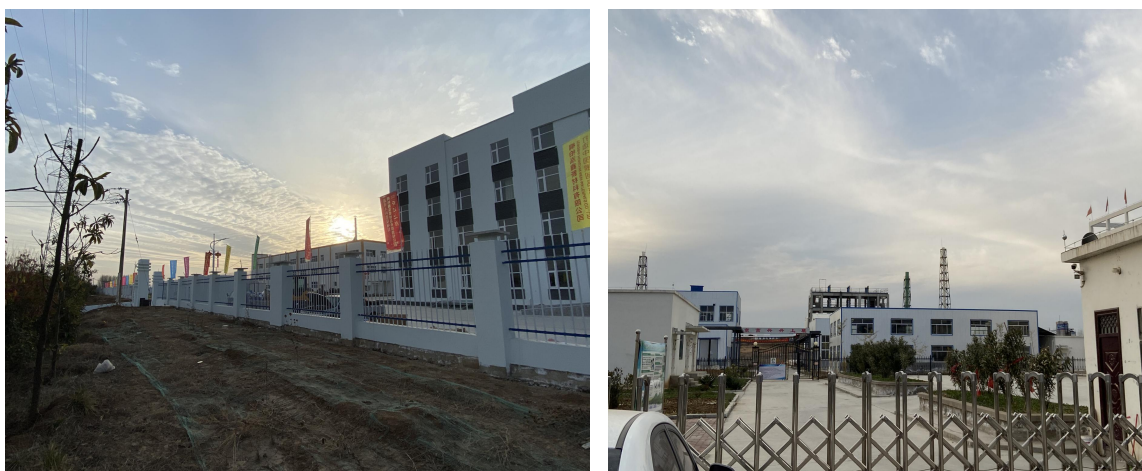
续照片 3-1 已采取水土保持措施
